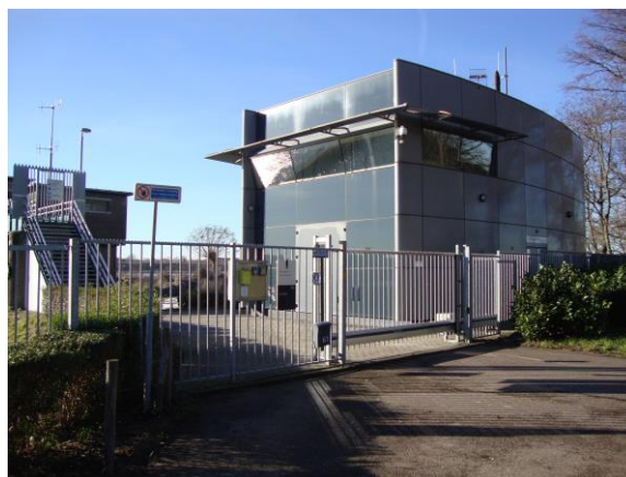
Bedrijfsgebouw tje stuwcomplex
