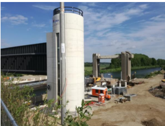
Nieuwe kersluis Julianakanaal (rechts sloop oude sluis)
