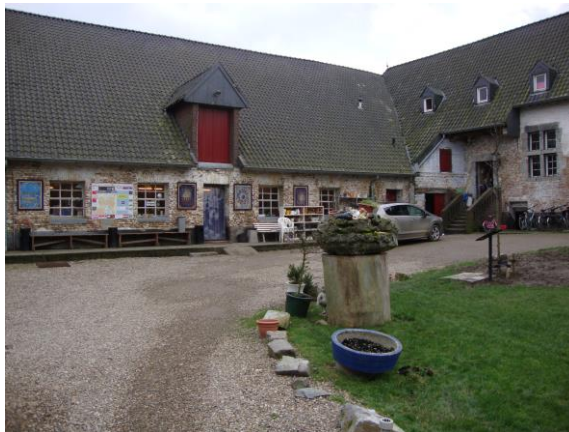
Monumentale hoeve (Hartelstein)
